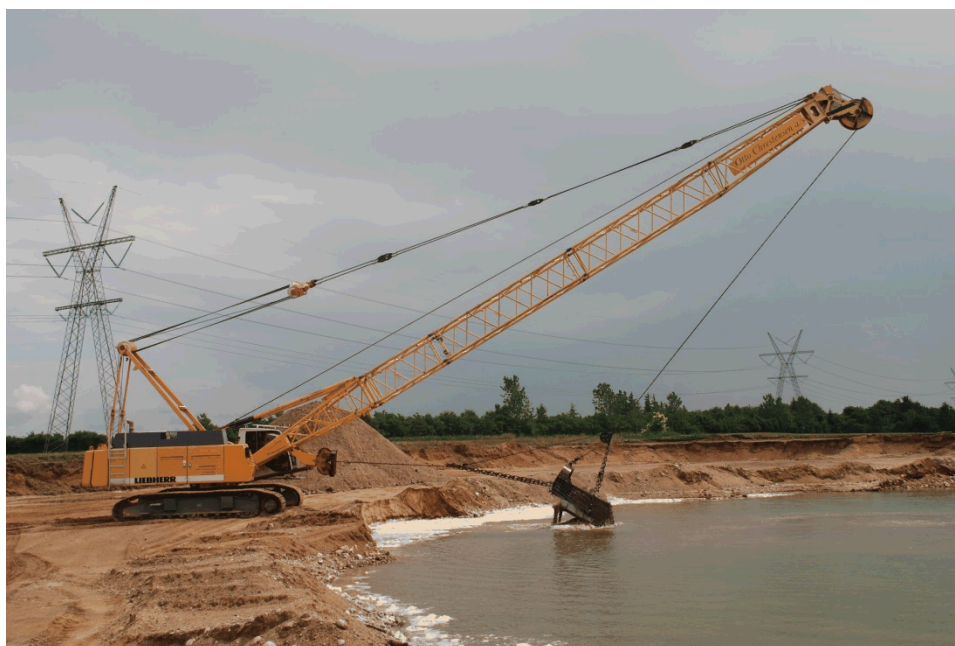
Figur 4.5: Wiregravemaskine, der undtagelsesvis anvendes til indvinding under grundvandsspejl, når sugeren ikke er velegnet.
