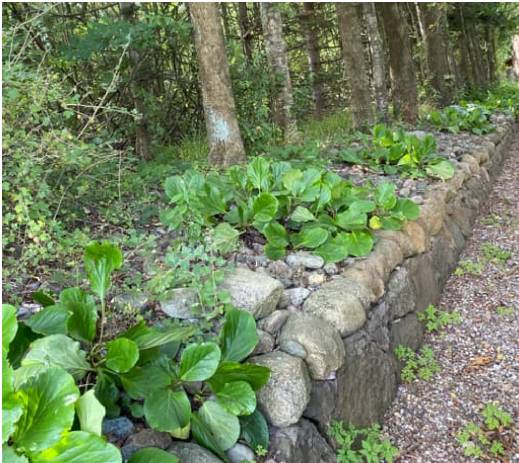
Figur 11-35: Dige ved ejendom nord for graveområde.
