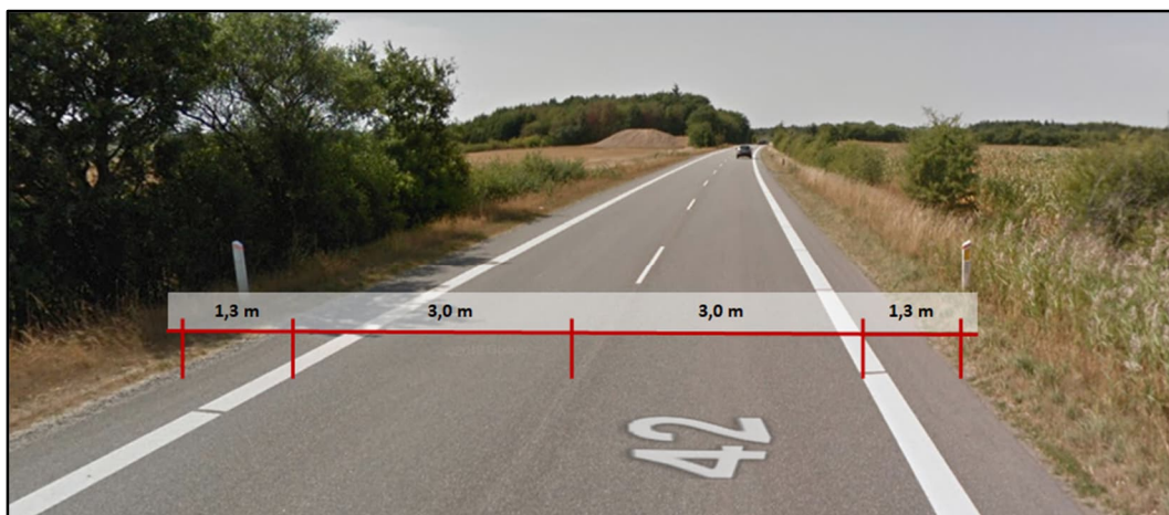
Figur 7-6: Udseende af Tinglevvej øst for Røllum Grusgrav med angivelse af vejbredden. Kilde: Google Street View.
