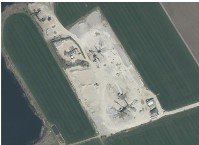
Figur 1: Luftfoto sorteringspladsen fra april 2023. Figuren er nordvendt og ikke i mål.
