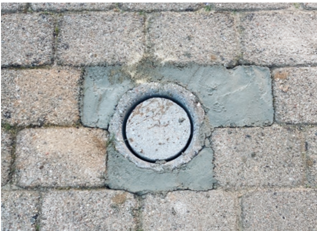
Figur 4: Filtersat boring med betonaflutning i niveau i hhv. flisebelægning og græsplæne.
