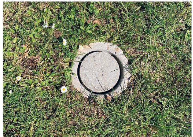
Figur 4: Filtersat boring med betonaflutning i niveau i hhv. flisebelægning og græsplæne.
