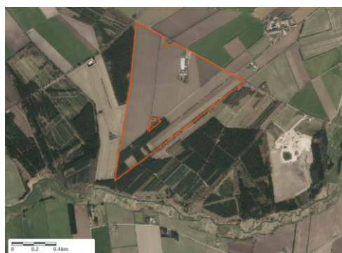
Figur 6-9. Luftfoto fra 2018, der viser dyrkningsmønstret.
