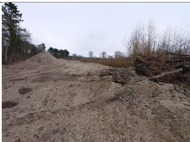
Foto 9: Det afgravede område set mod nord, mod flocculatoren
