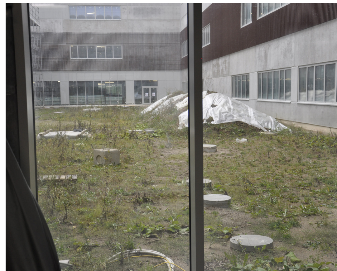
Det skal være muligt at tilgå og drifte gårdrum uden brug af store maskiner.
