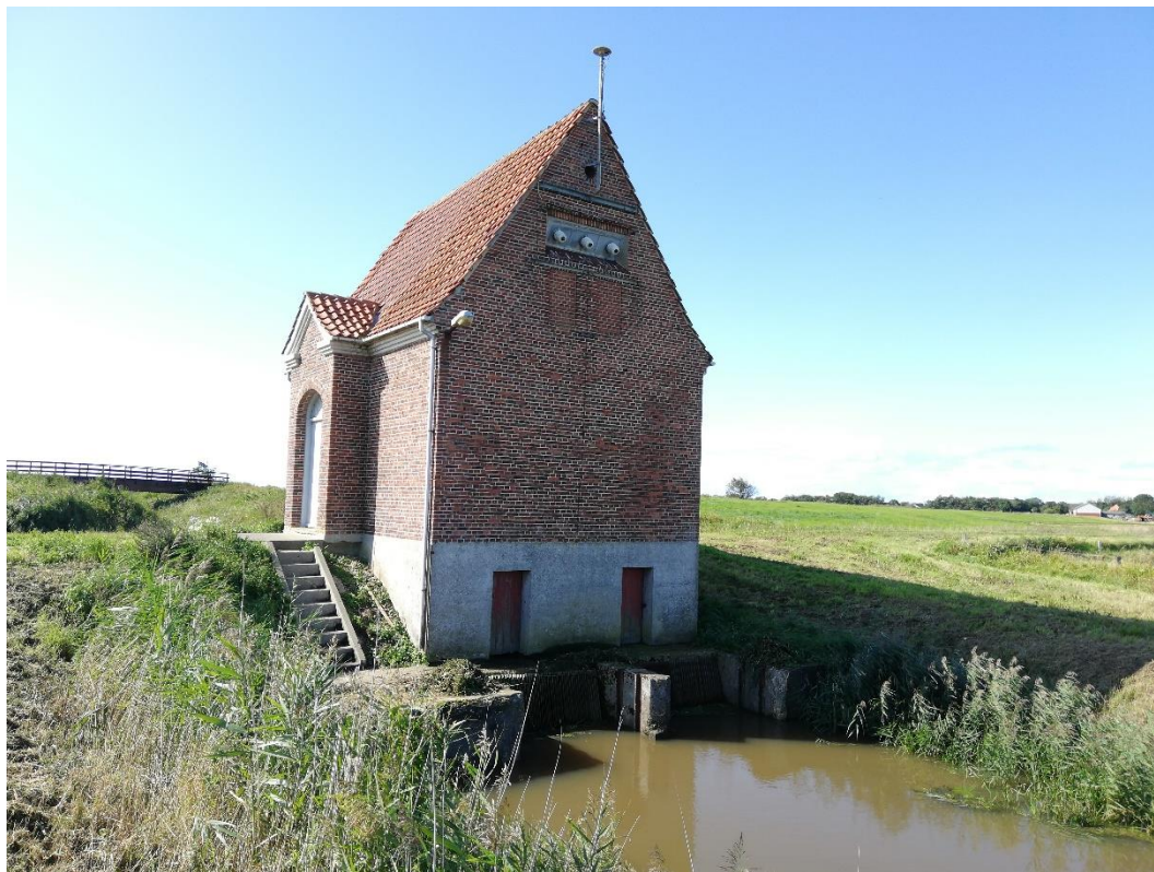
Figur 6-1. Foto af Snurom Pumpestation.
