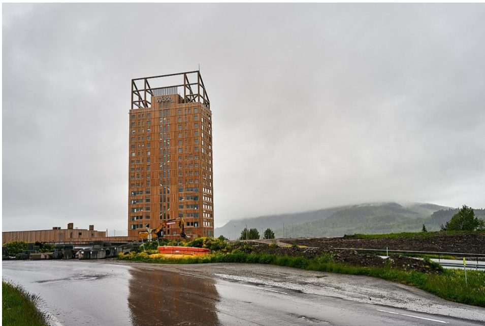
Figur 2. Mjøstårnet, Norge. Træhus i 18 etager, 85 m højt.
