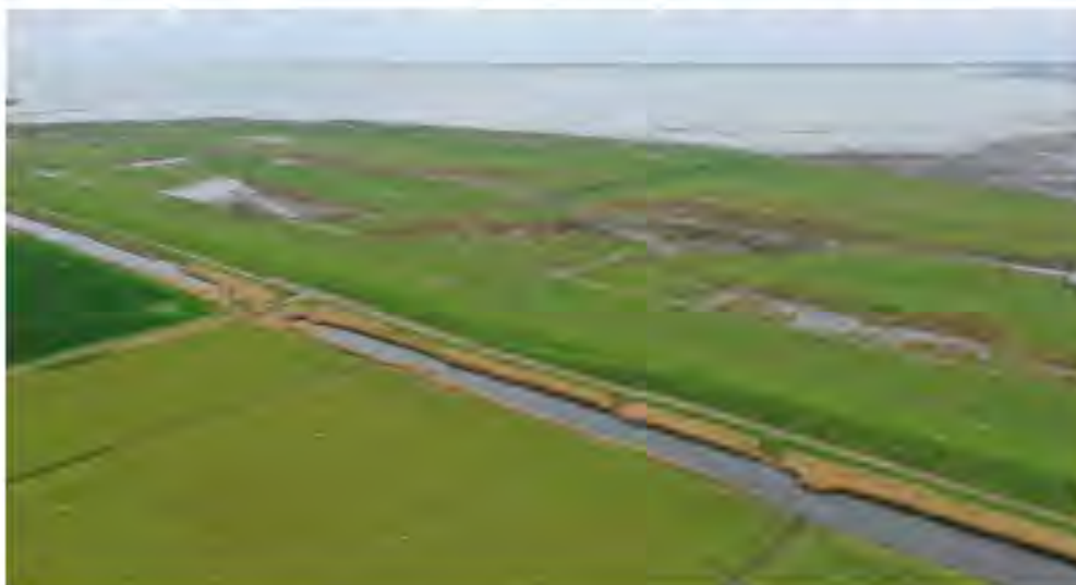
Figur 3-3 Ud over den eksisterende vej over fyldgraven, vil der etableres interimsvej til grusvejen langs diget. (Foto: Torben Ebbensgaard).
