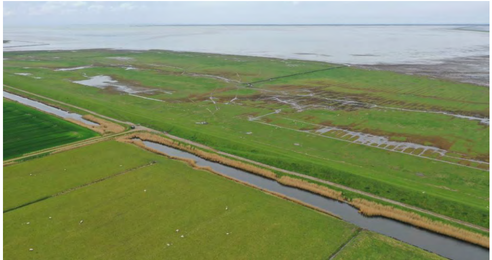
Figur 3-3 Ud over den eksisterende vej over fyldgraven, vil der etableres interimsvej til grusvejen langs diget. (Foto: Torben Ebbensgaard).
