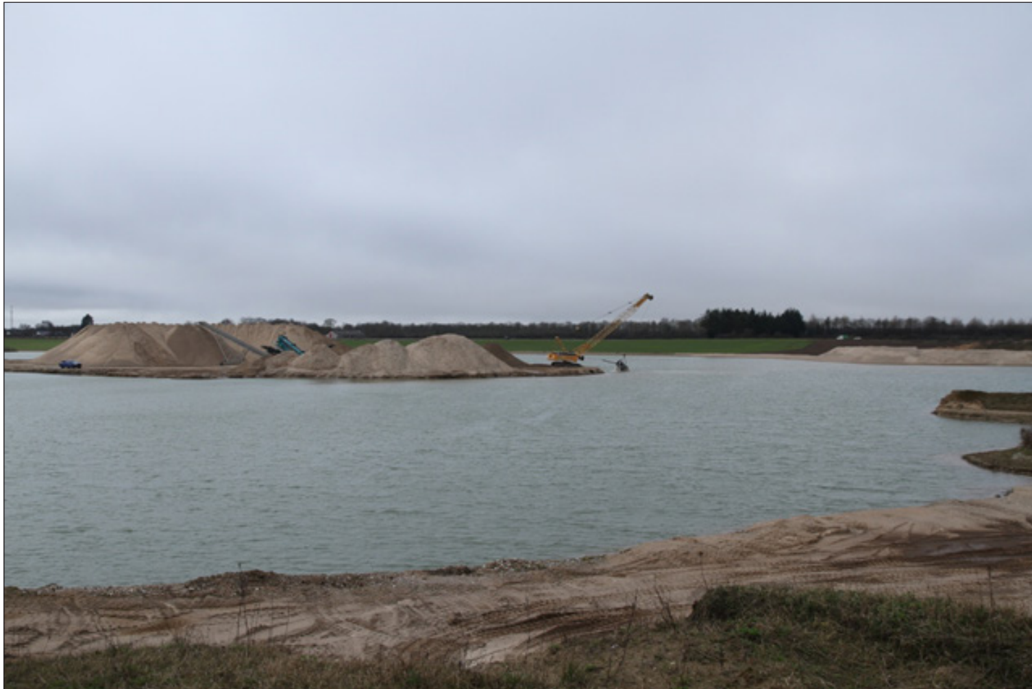
Wiremaskine og lagerstakke til afvanding på de eksisterende gravearealer.
