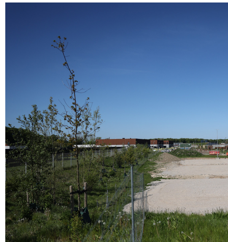
Eableret hegn ved solcelleanlæg, Nyt OUH
