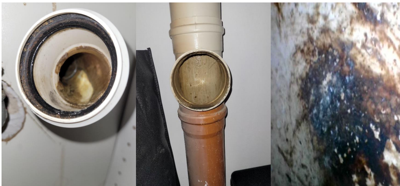
Figur 5.1: Biofilm/belægning af rørsystemer – venstre billede fra køkkenvask, midterste billede fra faldstamme og højre billede fra toilet.
