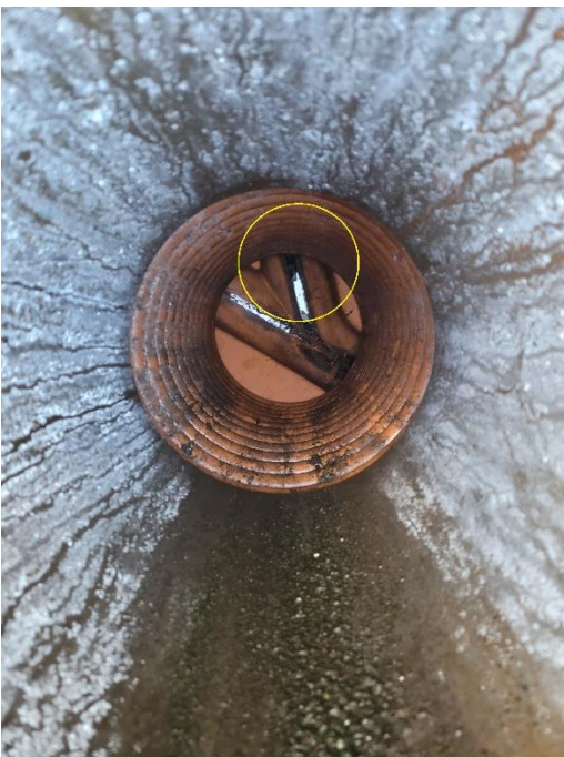
Samlebrønd i PVC-rør (gul ring indikerer prøvetagningsstreng)
